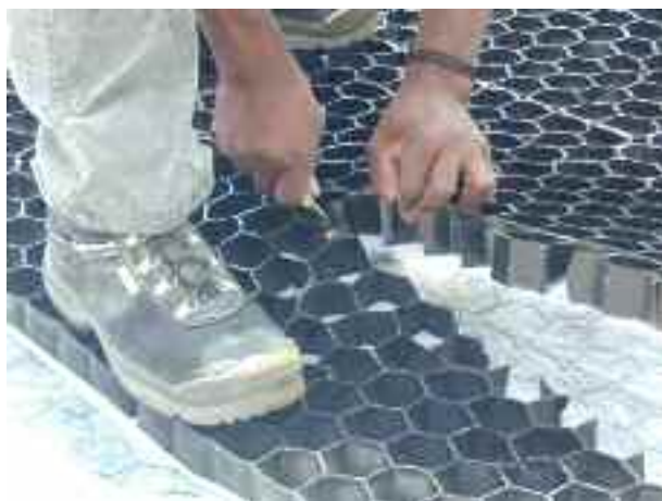
Les plaques Nidarooft se découpent aisément au cutter.
