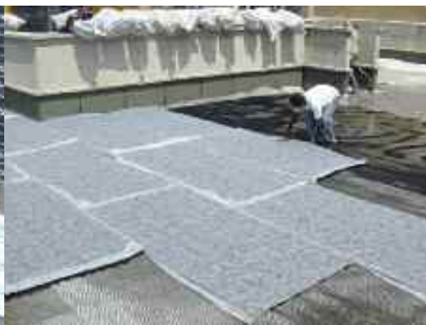
Le procédé Waterproof se met en œuvre en pose libre sur l'étanchéité bitumineuse Siplast.
