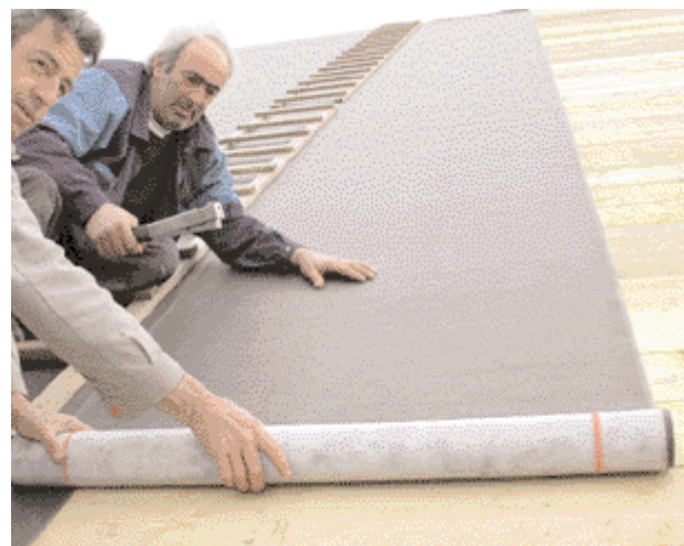
Pose de l'écran de sous-toiture FEL'X® MULTI
