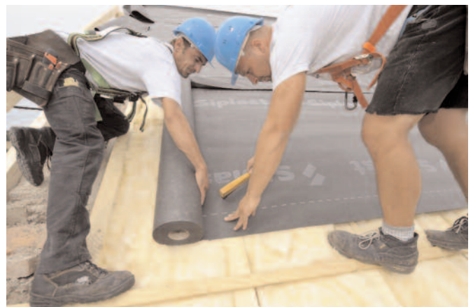
Hautement perméable à la vapeur d'eau, le nouvel écran de toiture Sup'Air peut se poser directement sur l'isolant.
