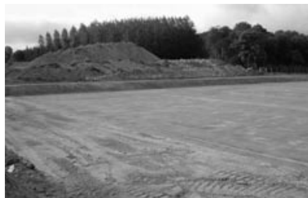
La zone à gauche n'est pas encore compactée.
