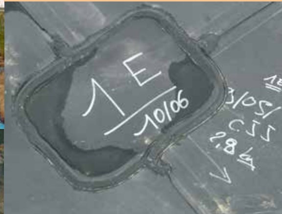
5- Controle des doubles soudures à canal central
