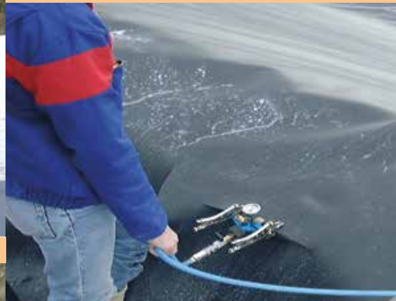
6- Controle des points singuliers à la cloche de vide
