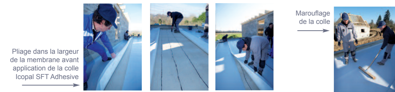
Réalisation de l'étanchéité au niveau du relevé
