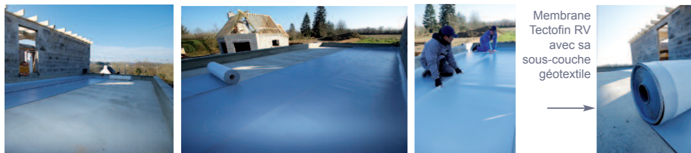
Déroutage et mise en place des lés de Tectofin RV
