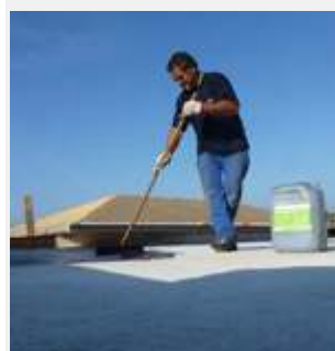
Répartition d'Eco-Activ Primer avant de l'appliquer à la brosse ou au rouleau
