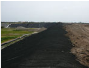
Mise en œuvre de Geogrip 80 et remblaiement des tranchées d'ancrage
