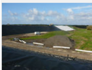
Vue d'ensemble des talus
