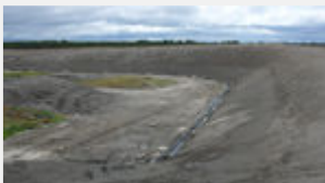
Végétalisation des talus terminée
