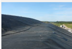
Mise en oeuvre terminée de Geonap sur talus
