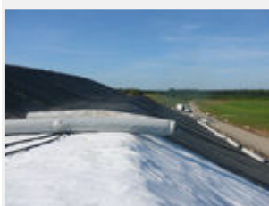
Pose du géotextile Geofelt Datex PR 500
