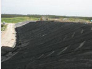
Pose de Geogrip 35 terminée
