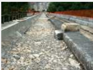
Etat des lieux - Ballast retiré
