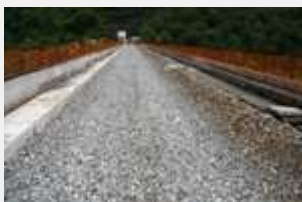
Etat des lieux - Ballast d'origine
